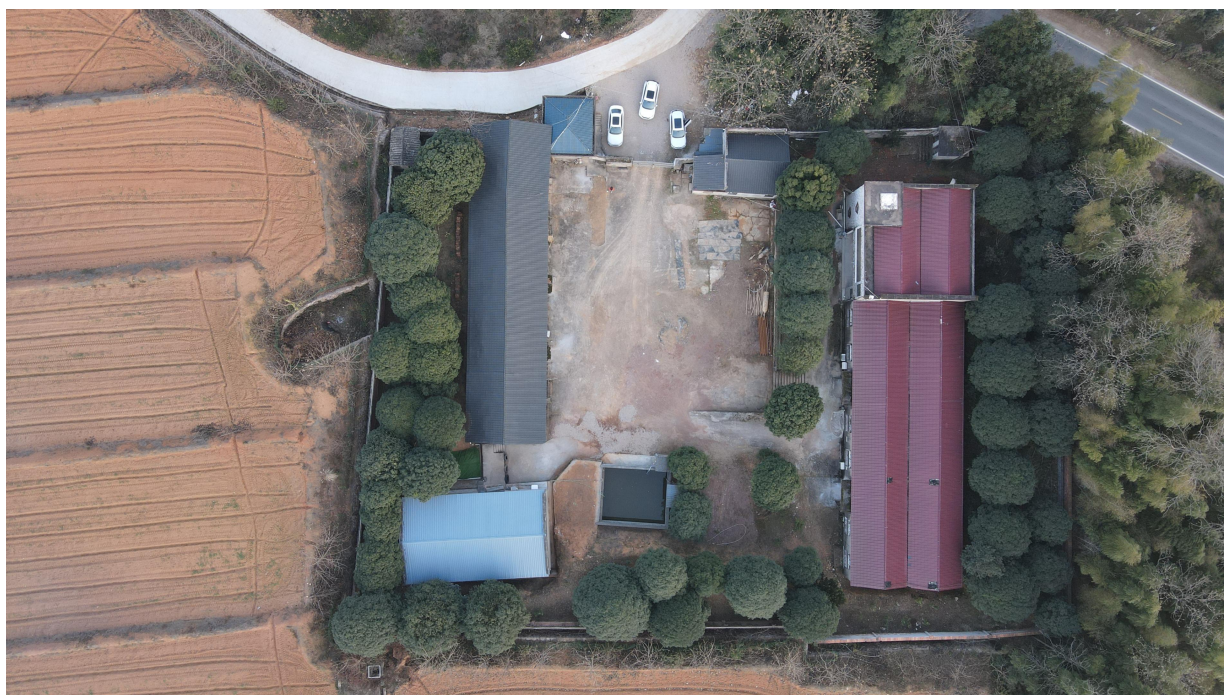
现场勘察时的库区航拍图
