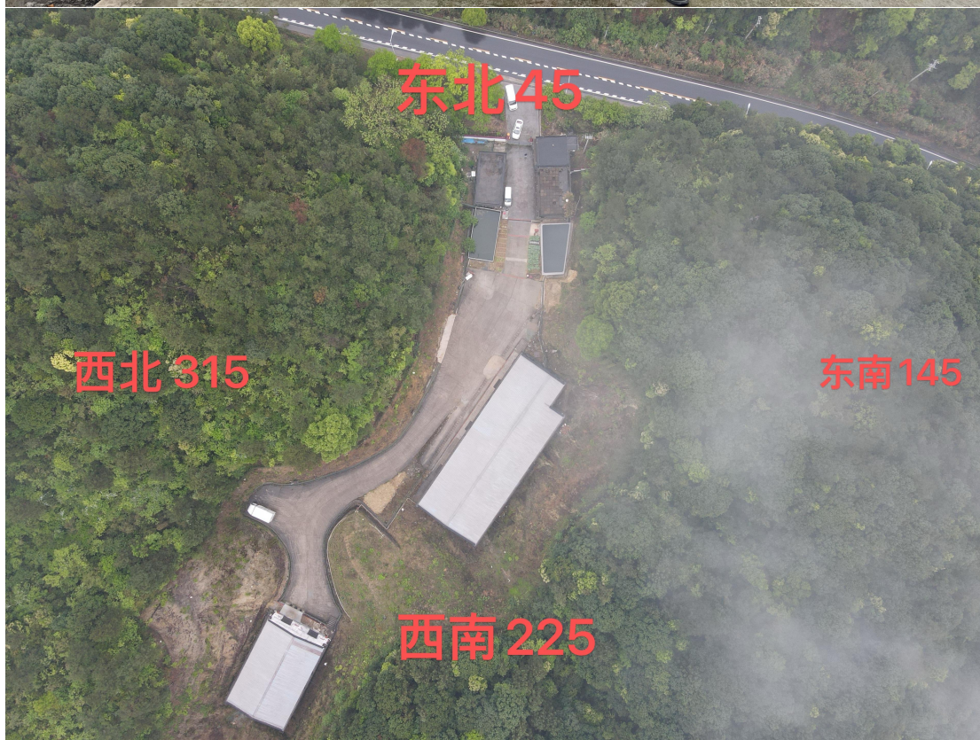
评价人员现场勘察照片
