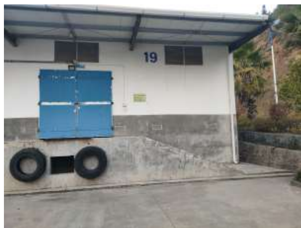
19#成品库未配备灭火器
