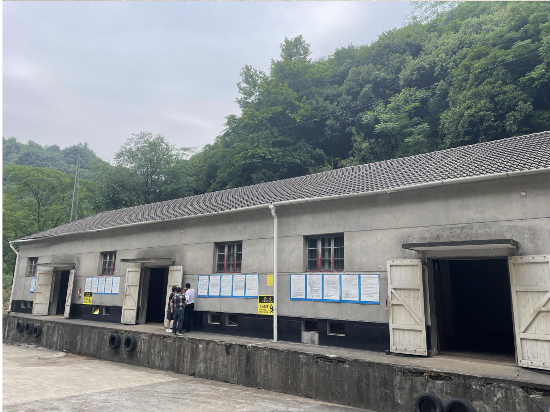
评价人员现场勘察照片
